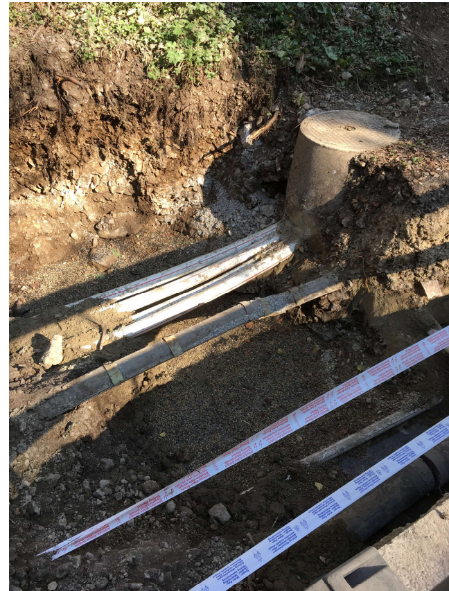
Sondage vers Ch. multiservices pour 2 vannes 8 avril 2020
