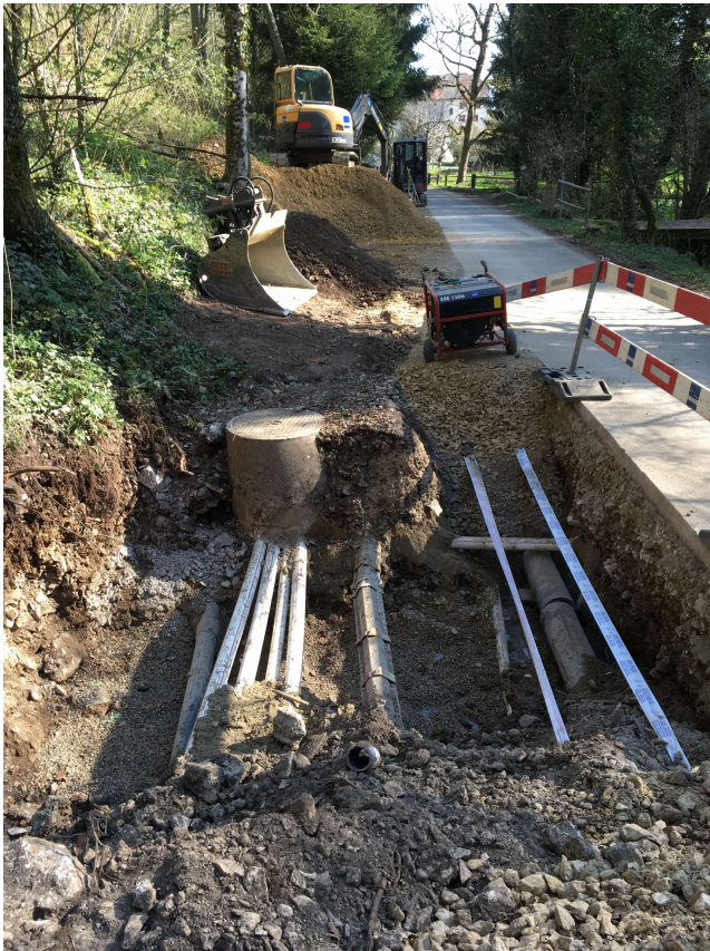
Sondage vers Ch. multiservices pour 2 vannes 8 avril 2020
