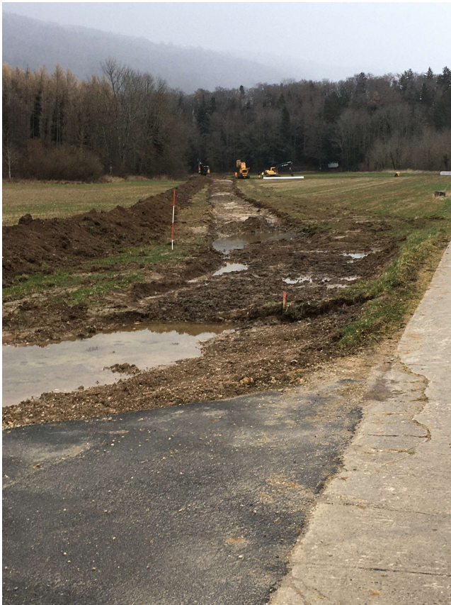
Fouille du trop plein après remblayage le 3 février 2020
