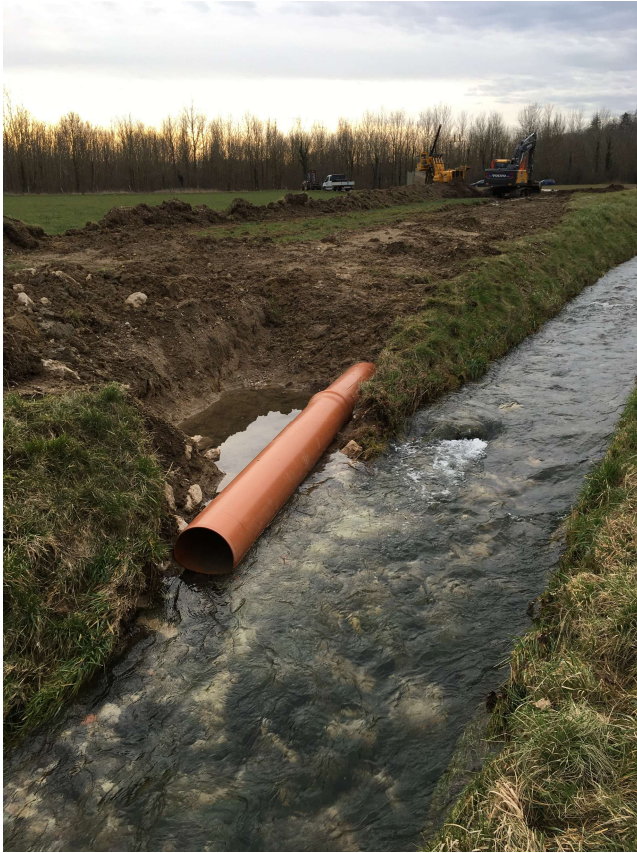
Sortie du trop plein dans la Baumine du 17-02 & 24-04 2020
