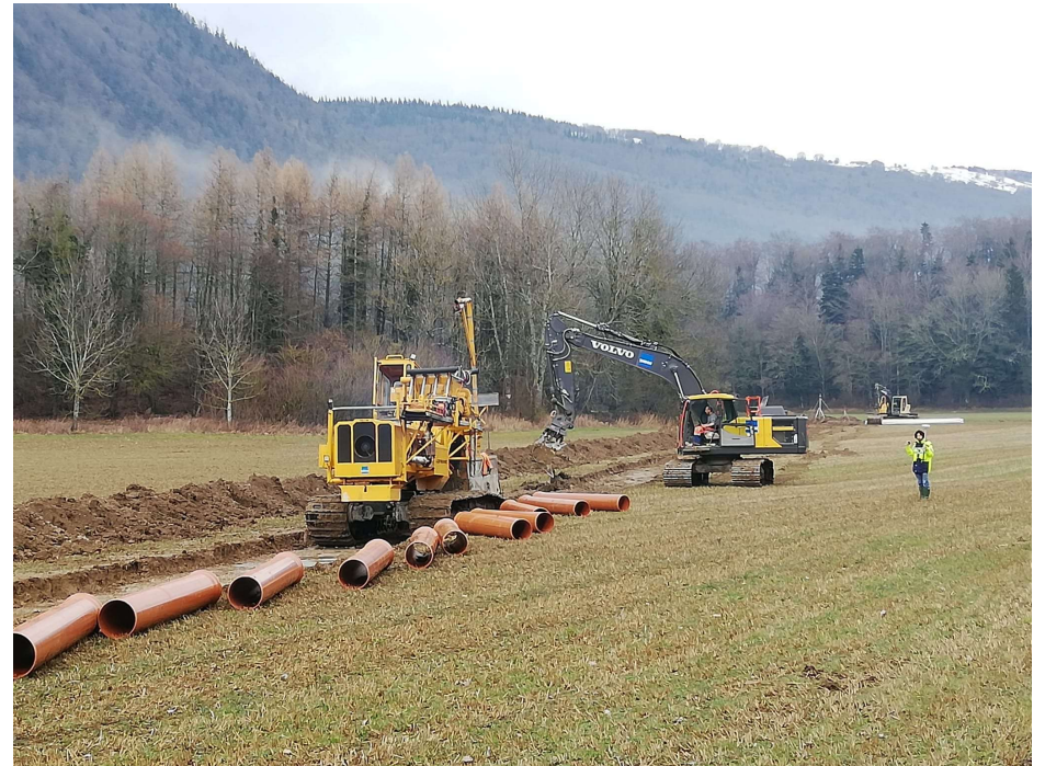
Travaux de pose du trop plein au début février 2020
