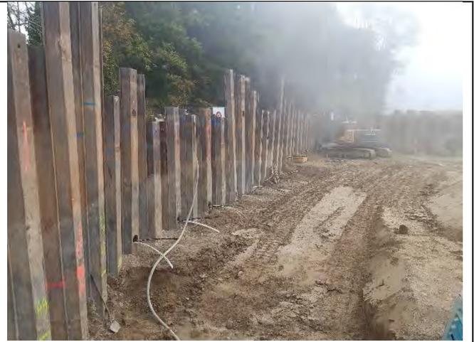
*Élévation E1 ancrages en cours de réinjections*
