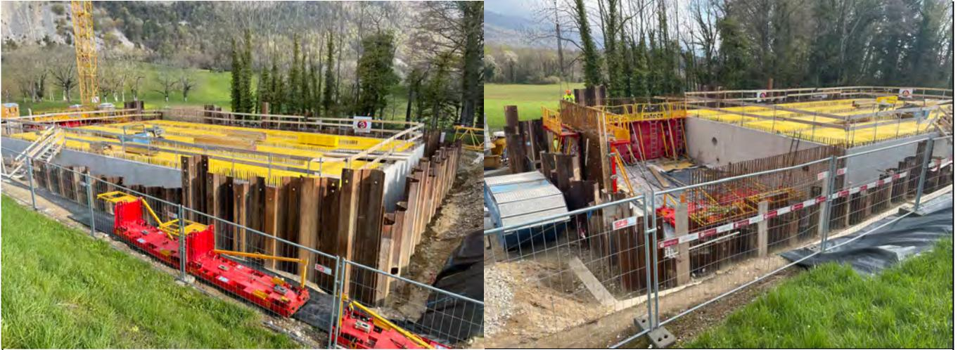
*Coffrage des murs du local technique et de la dalle des cuves*
