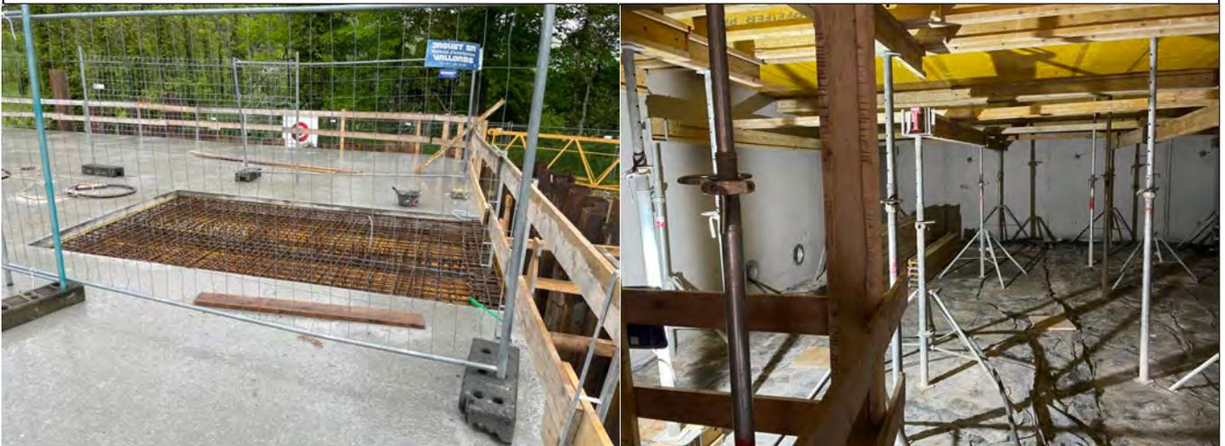
*Ferrillage du trou de sortie des étais de la dalle du toit*
