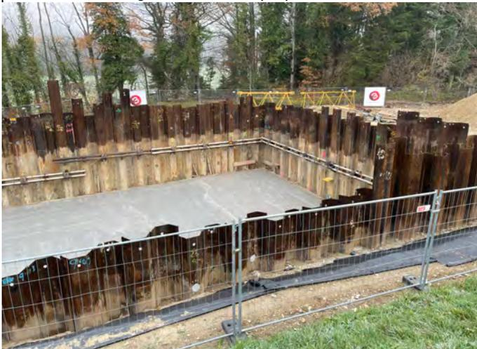
*Béton maigre du radier de propreté des cuves*
