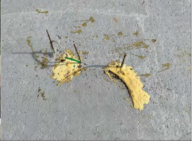
*Trou de sortie des étais depuis la dalle bétonnée et tubes pour l'injection dans les joints d'étanchéités*
