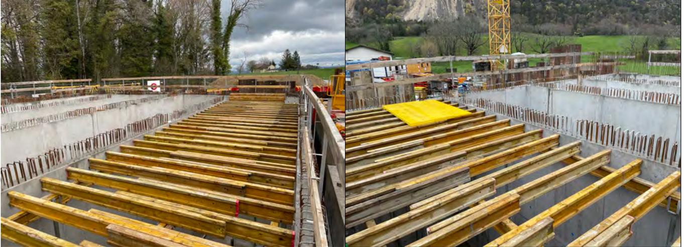
*Les murs des réservoirs sont terminés, préparation du coffrage de la dalle du plafond*
