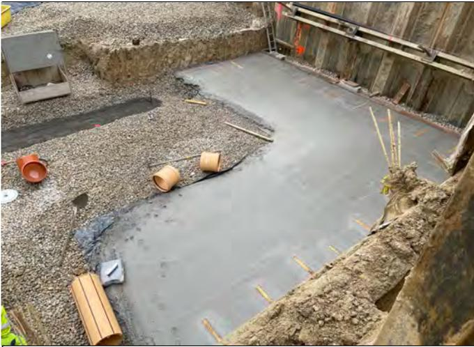
*Bétonnage du radier de propreté du local technique*
