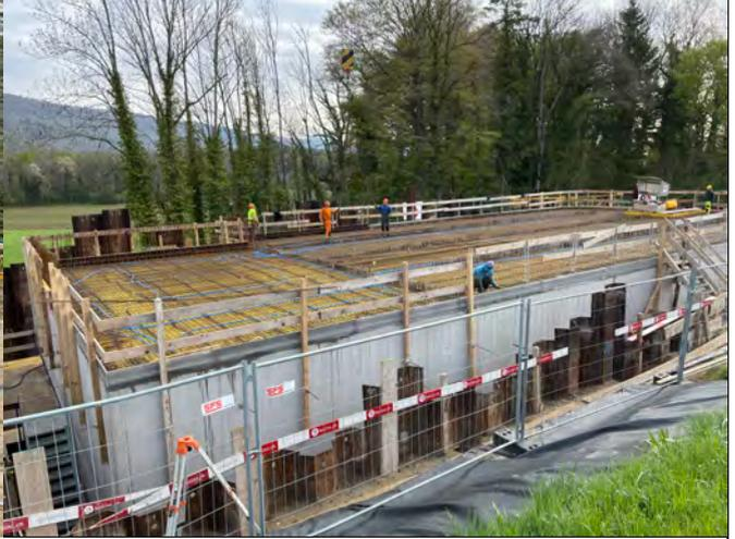
26 avril 2023 Ferrailage de la dalle du plafond du réservoir
