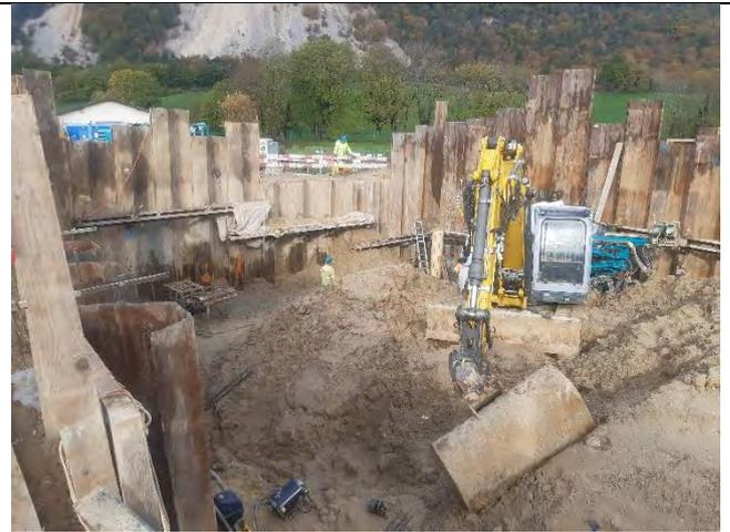
*Réinjections en cours sur le 2ème rang d'ancrages*
